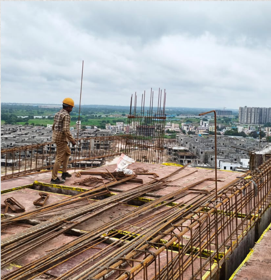
Pour 2 Slab reinforcement work in progress.
